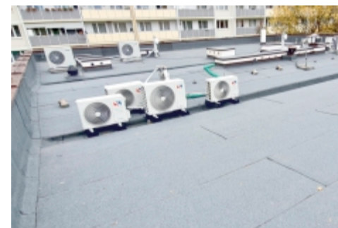
Ul. Wielkopolska 132 - remont dachu
