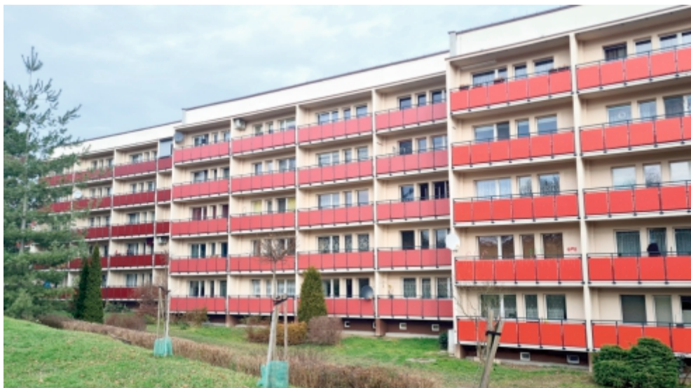
Ul. Kusocińskiego 25-43 - wymiana balustrad
