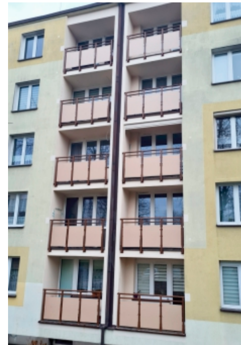
Ul. Wyszyńskiego 45-49 - wym. balustrad
