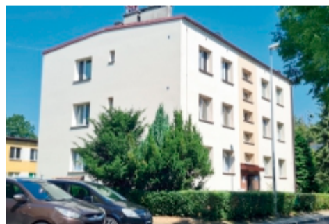
Ul. Konopnickiej 2 - docieplenie
